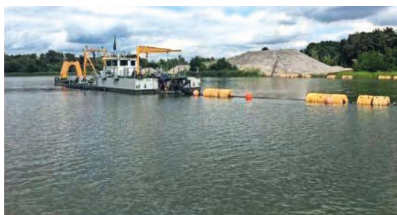
Erstellung eines Sanddepots mit einem Saugbagger.
